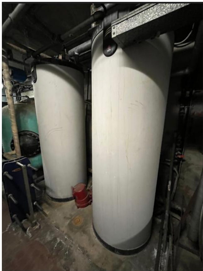
Fig. 10. Bollitori per la produzione di ACS
