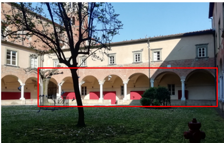
Murature da consolidare a piano terra su chiostro interno
