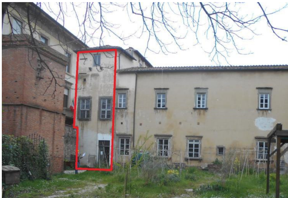
Localizzazione di ponteggio sull'area di cantiere per l'accesso al piano secondo
