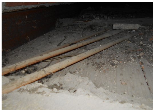
Controsoffitto in longarine e tavelloni visto alla botola di accesso
