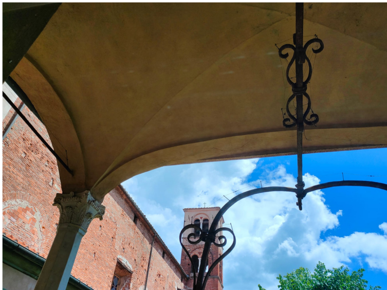
Mancanza di catena metallica longitudinale
