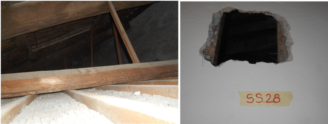
Controsoffitto in intonaco armato visto dal saggio effettuato
