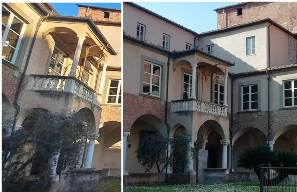
Mancanza di catena metallica longitudinale
