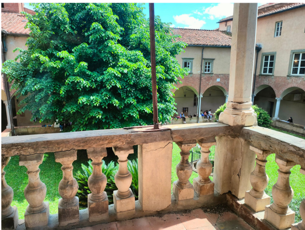
Lesioni sui pilastri in muratura
