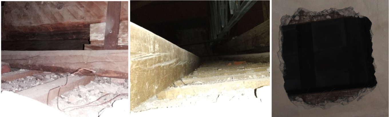
Controsoffitto in intonaco armato visto dal saggio effettuato
