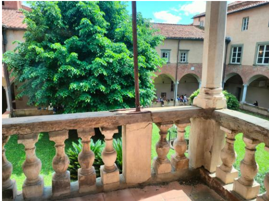
Lesioni sui pilastri in muratura
