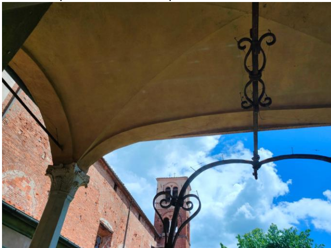
Mancanza di catena metallica longitudinale
