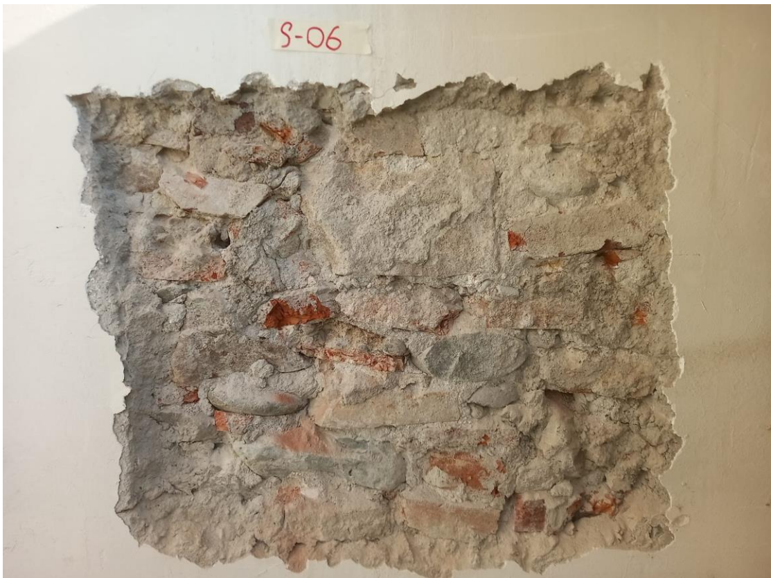
Foto 10. Rappresentativa Ispezione diretta su muratura denominata "S_06"
