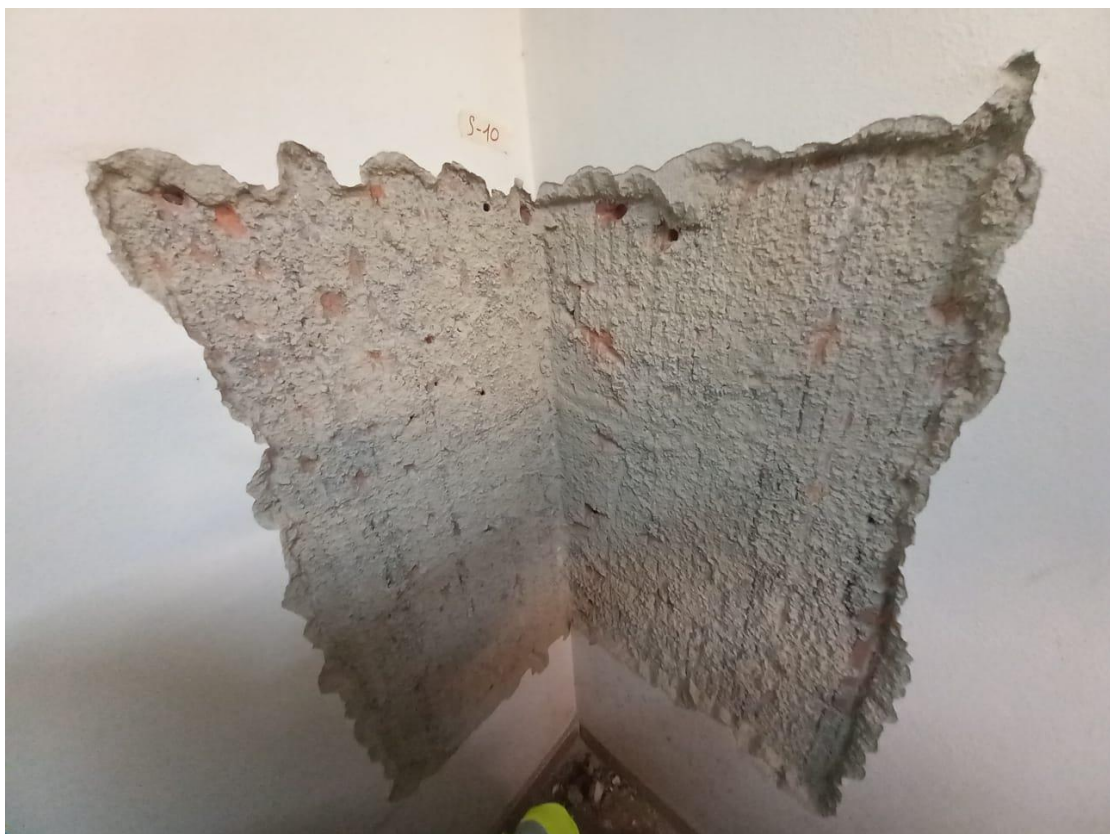
Foto 14. Rappresentativa Ispezione diretta su muratura denominata "S_10"
