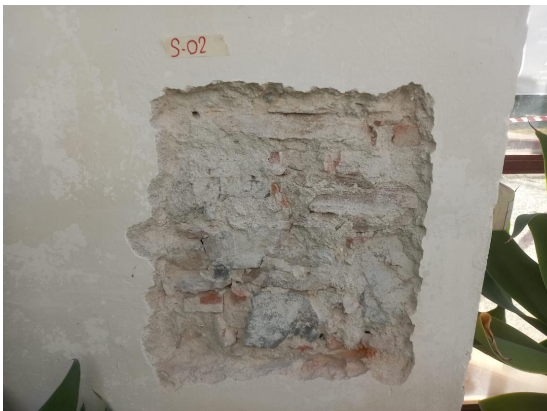
Foto 6. Rappresentativa Ispezione diretta su muratura denominata “S_02”
