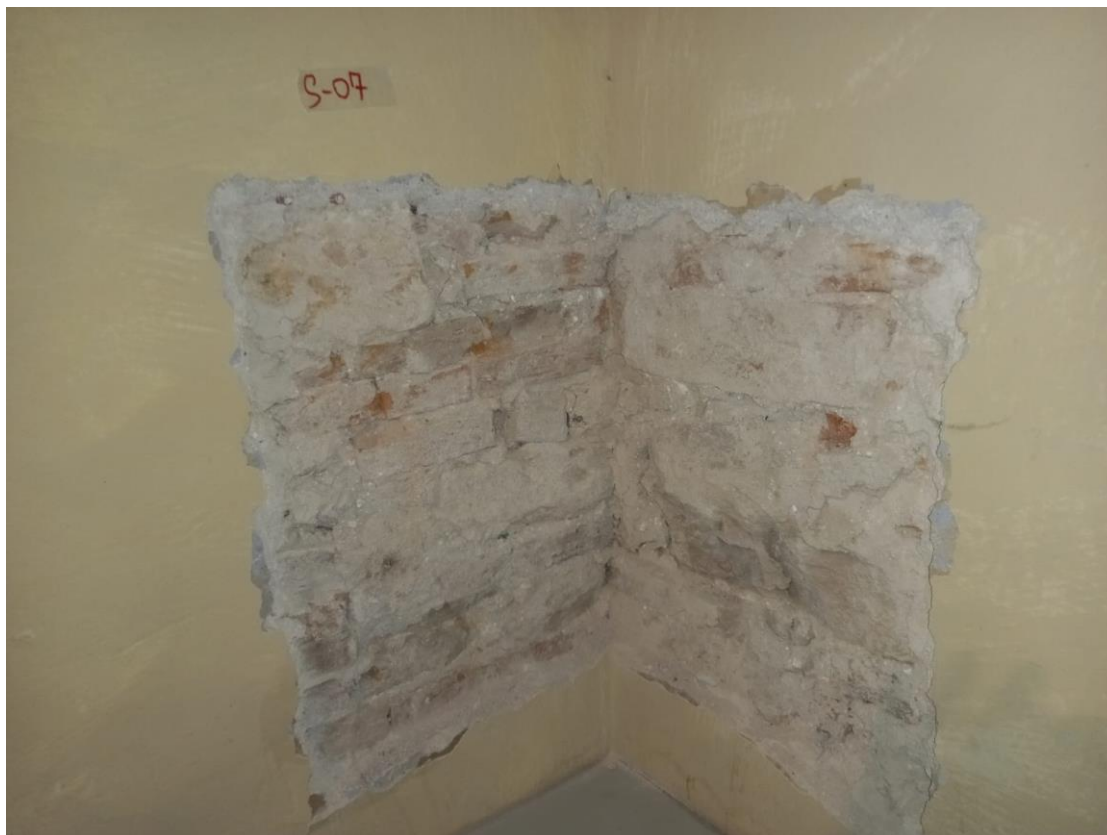
Foto 11. Rappresentativa Ispezione diretta su muratura denominata "S_07"
