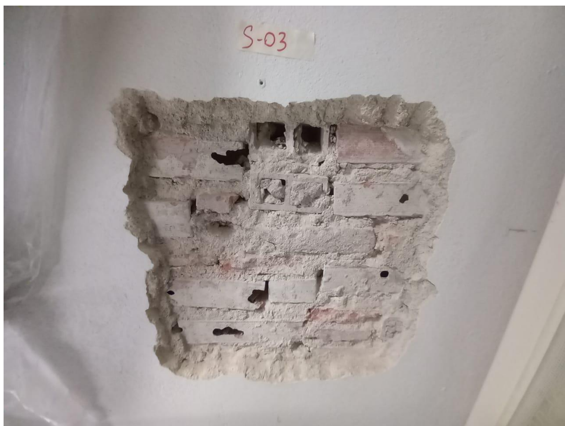
Foto 7. Rappresentativa Ispezione diretta su muratura denominata "S_03"
