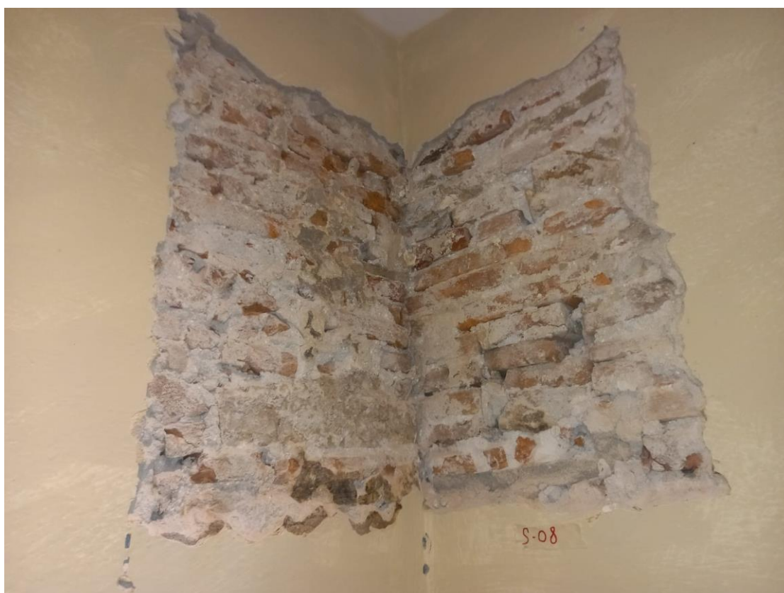
Foto 12. Rappresentativa Ispezione diretta su muratura denominata "S_08"
