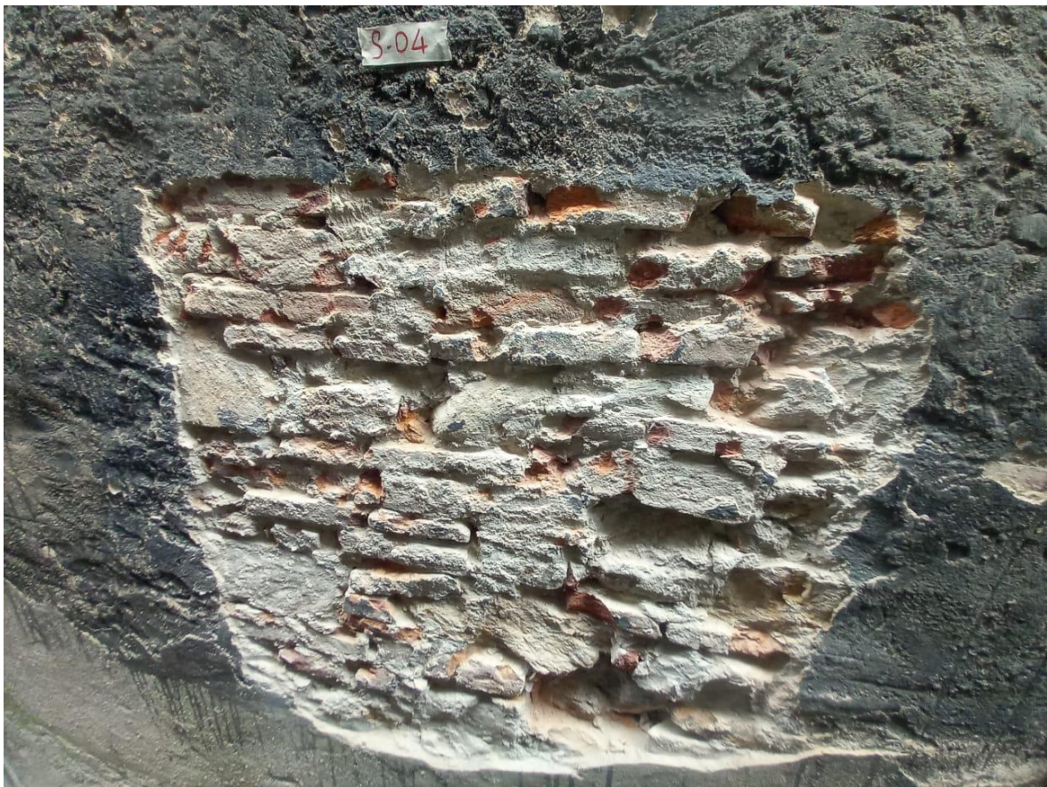
Foto 8. Rappresentativa Ispezione diretta su muratura denominata “S_04”
