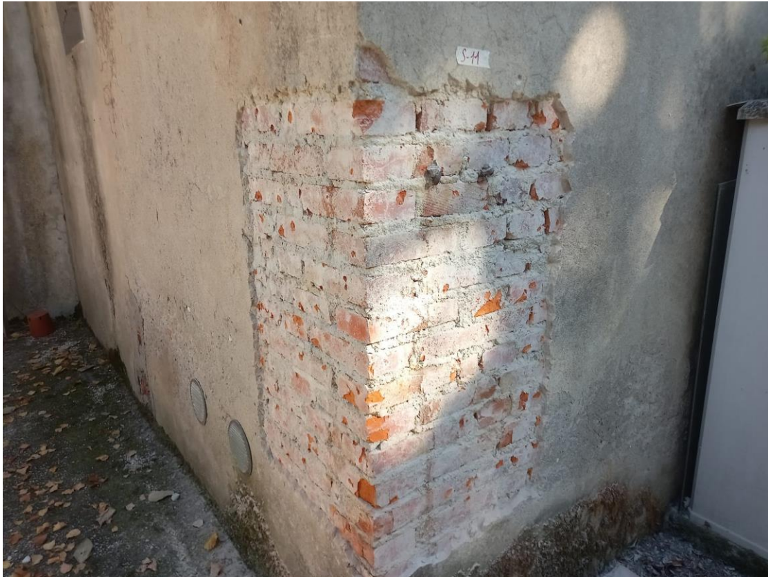
Foto 15. Rappresentativa Ispezione diretta su muratura denominata "S_11"
