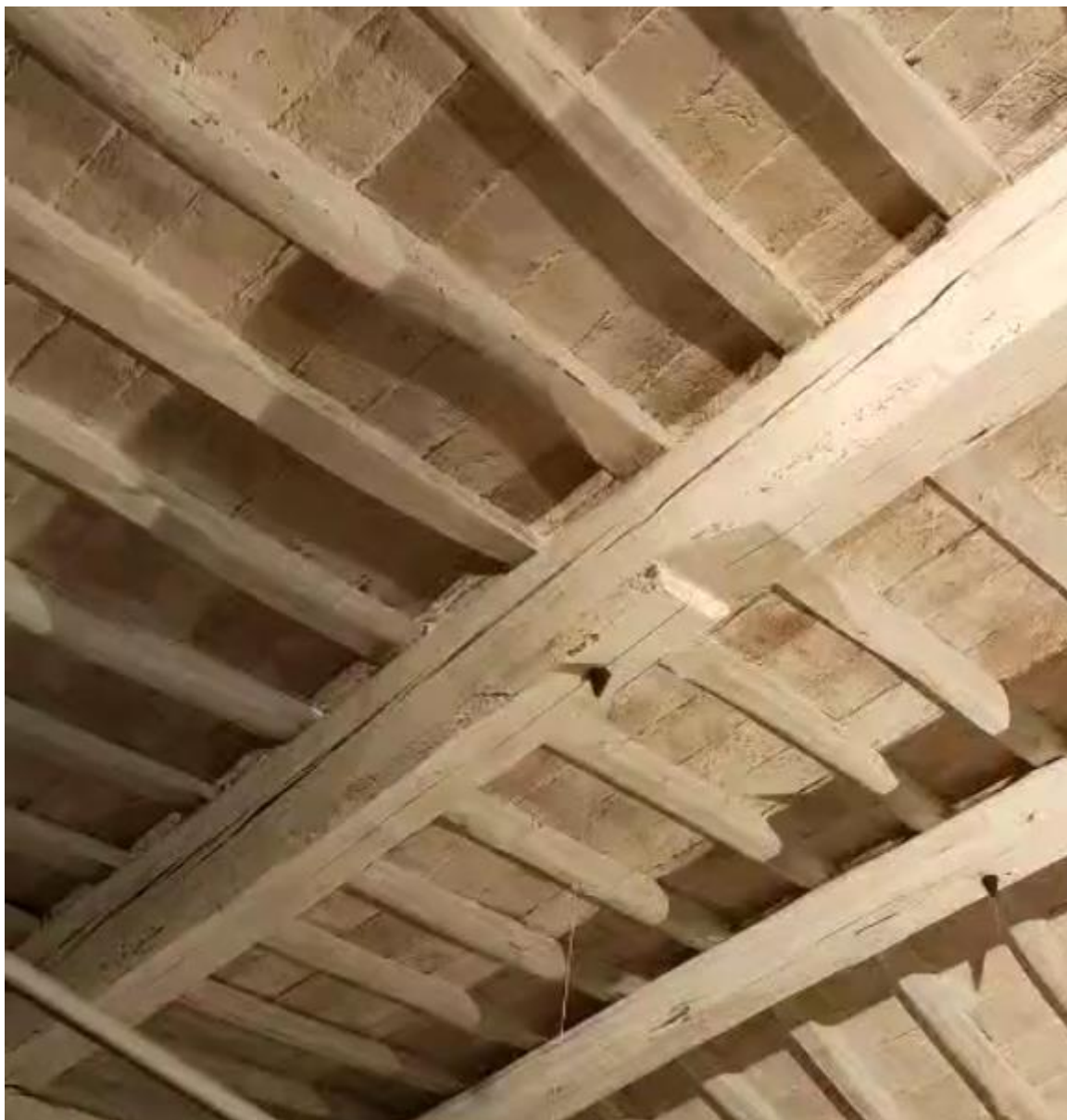
Riutilizzo di una travatura esistente
