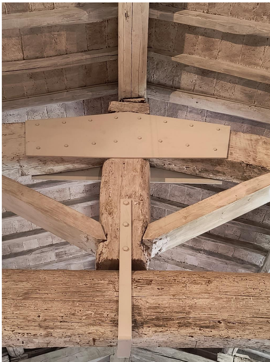
Intervento di rinforzo di una capriata collassata
