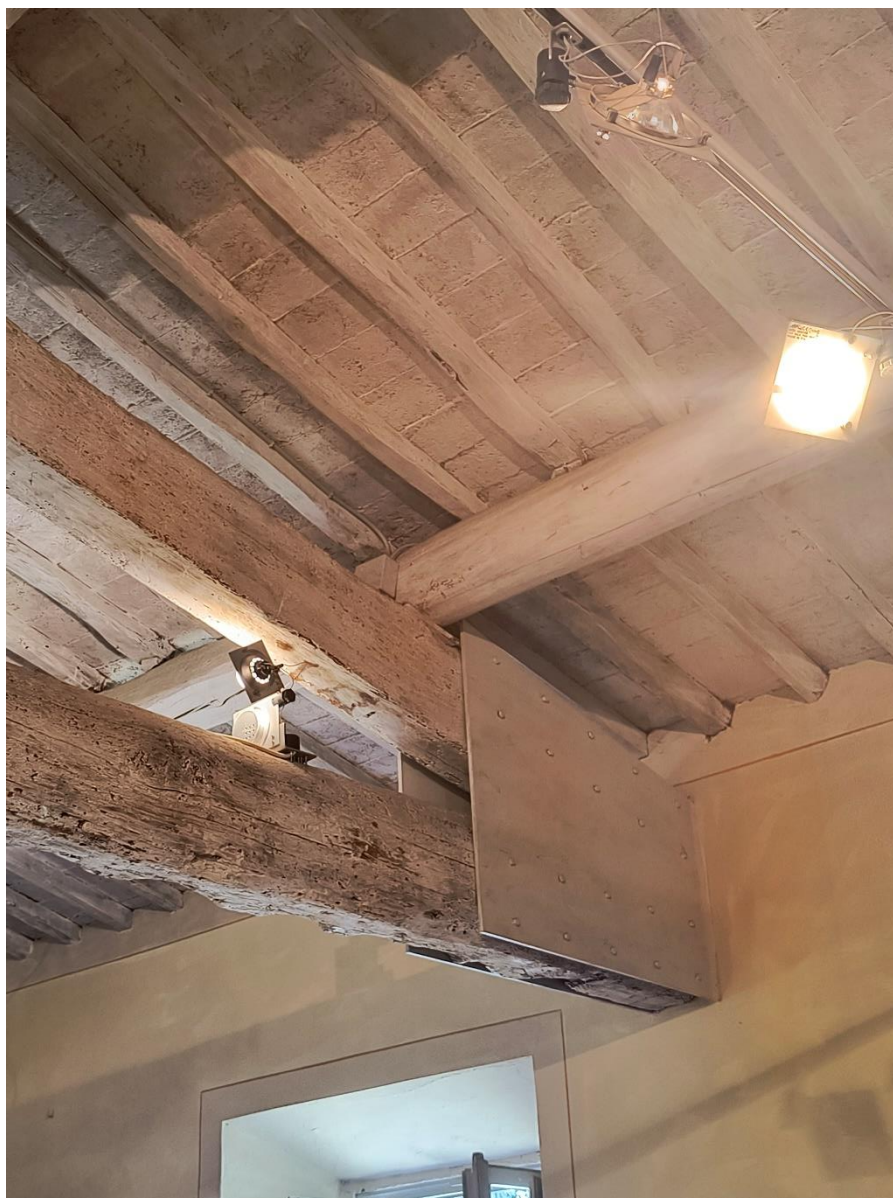
Rinforzo della porzione di appoggio di una capriata
