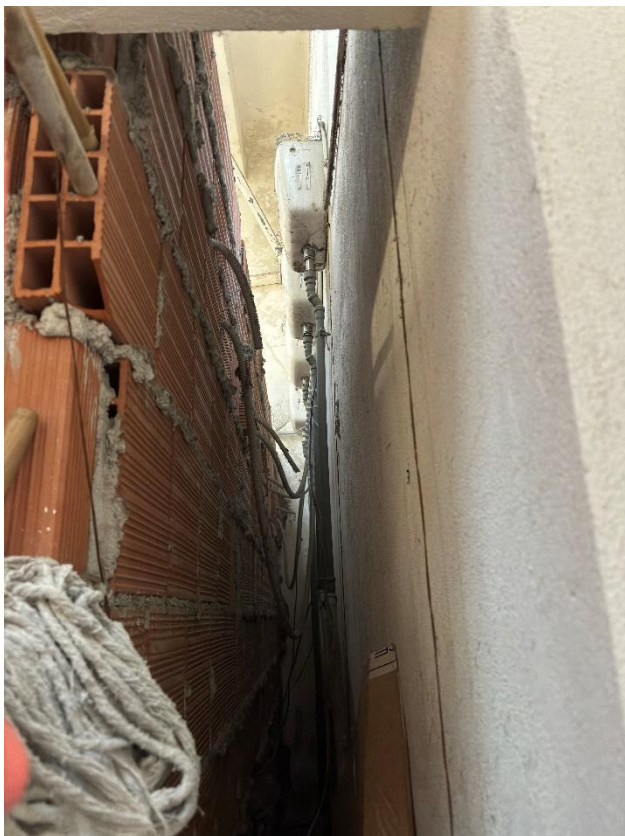
15_Vano tecnico dietro servizi donne
