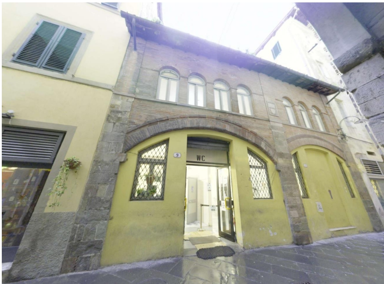
2_ Facciata Via Pescheria
