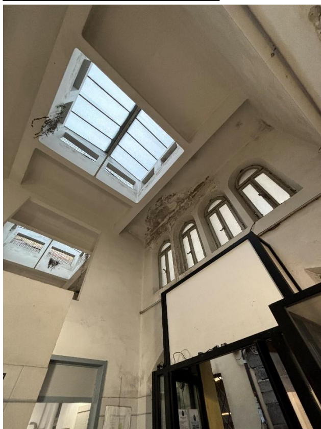
5_ Vista delle finestre al piano primo e lucernario nell'atrio
