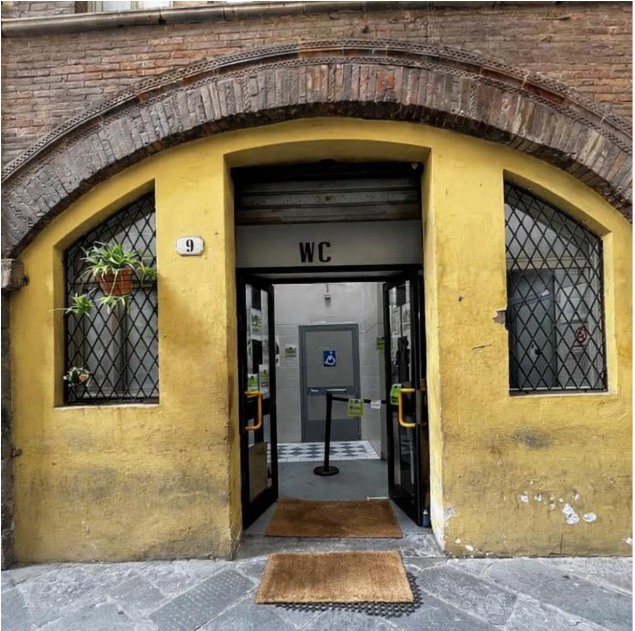
1_ Ingresso da Via Pescheria
