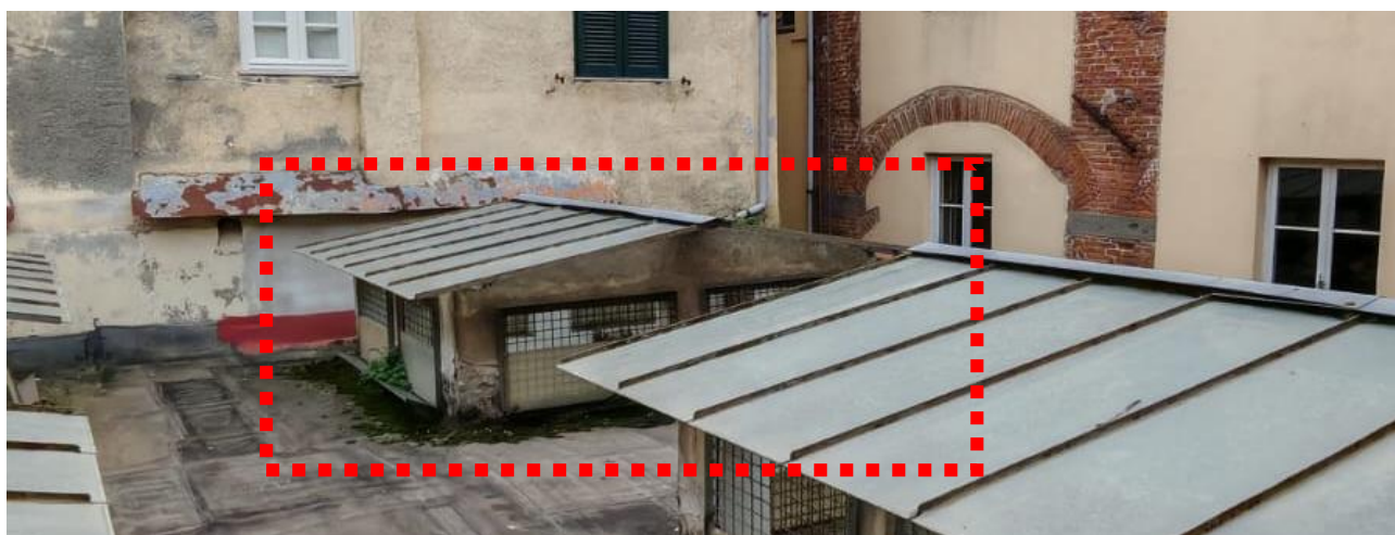
Lucernario esistente oggetto di modifica
