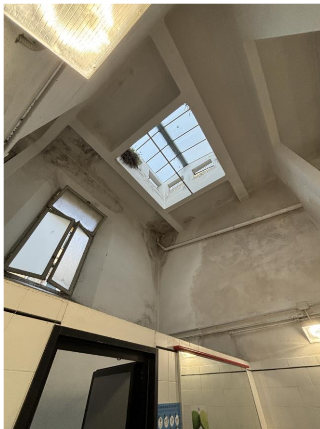
Locale Servizi uomini
