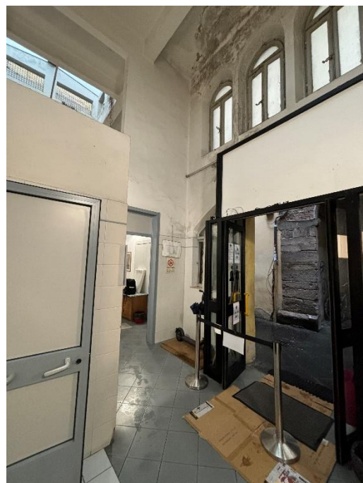
Infisso di ingresso dall'interno
