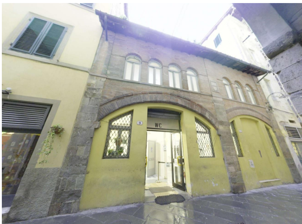
Facciata su Via Pescheria
