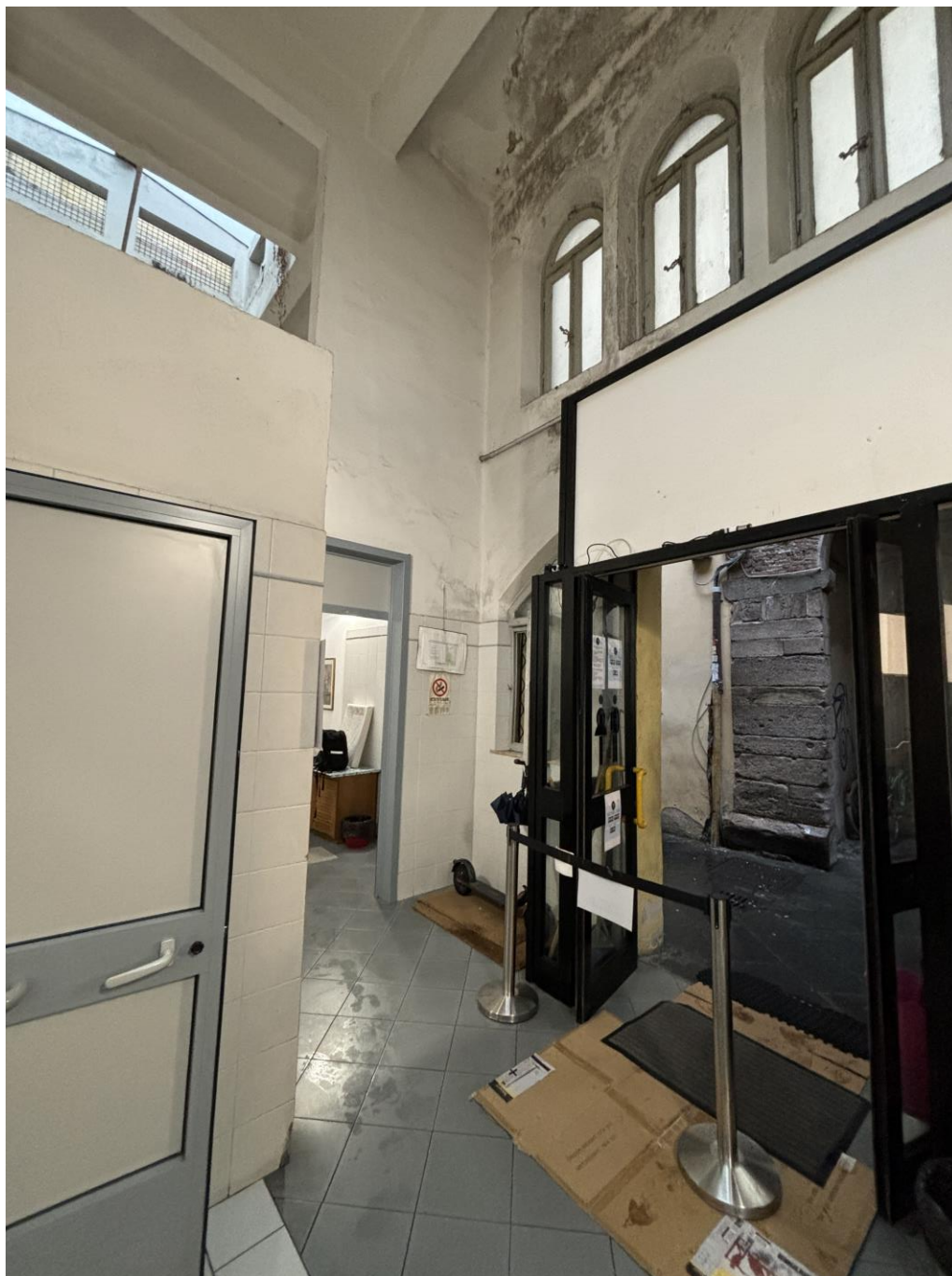
Vista ingresso – Stato di fatto
