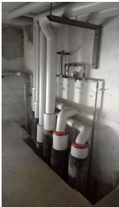
Apertura esistente nel solaio fra piano terra e piano primo della centrale termica
