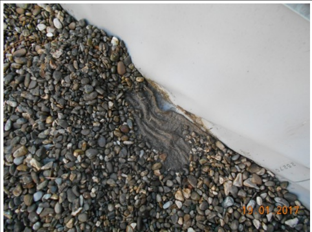
Particolare del ricoprimento della copertura piana
