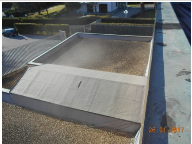
Solaio di copertura del Blocco C e D
