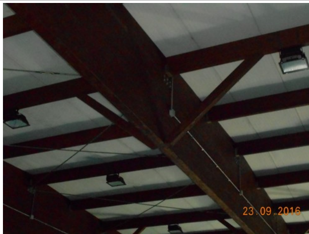
Particolare in mezzeria della trave di copertura del Blocco A
