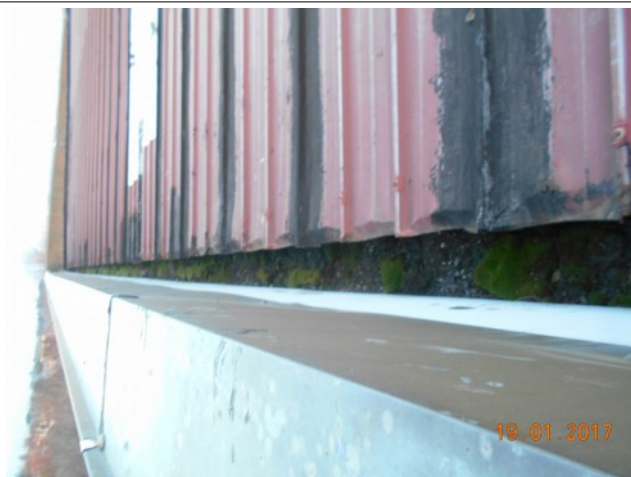
Particolare della grondaia della copertura del Blocco A
