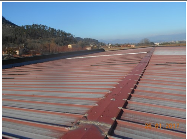
Linea di colmo della copertura del Blocco A
