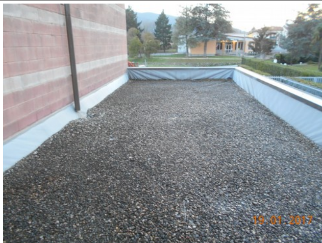
Solaio di copertura del Blocco E
