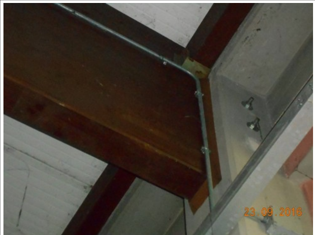
Particolare in appoggio della trave di copertura del Blocco A
