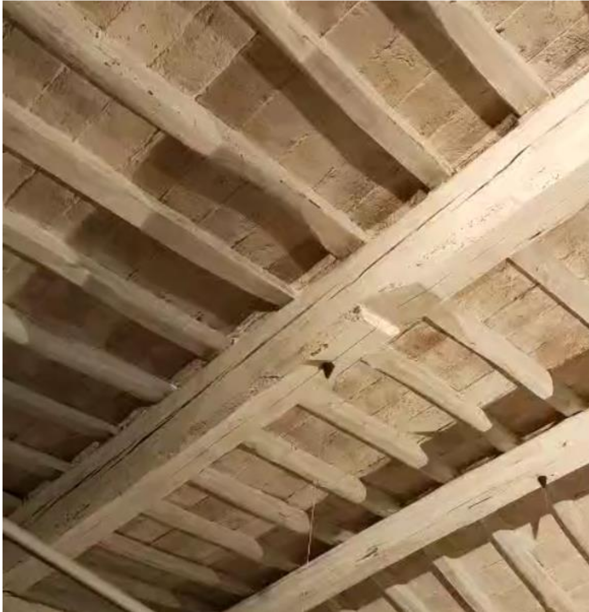
Riutilizzo di una travatura esistente
