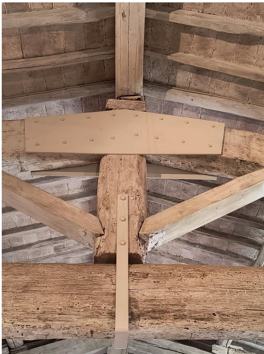
Intervento di rinforzo di una capriata collassata
