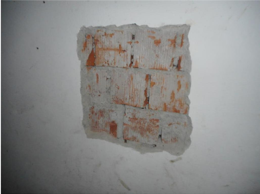
*Foto Saggio P1 - Struttura Muraria perimetrale*
