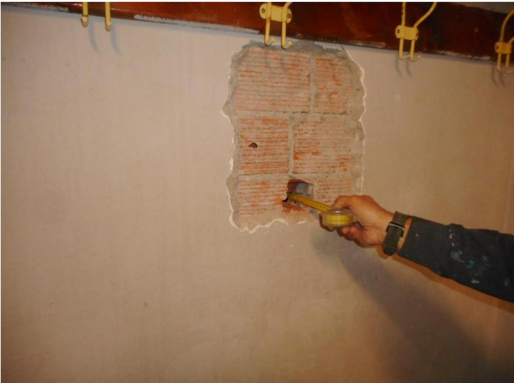
*Foto Saggio P2 - Struttura Muraria setti centrali*
