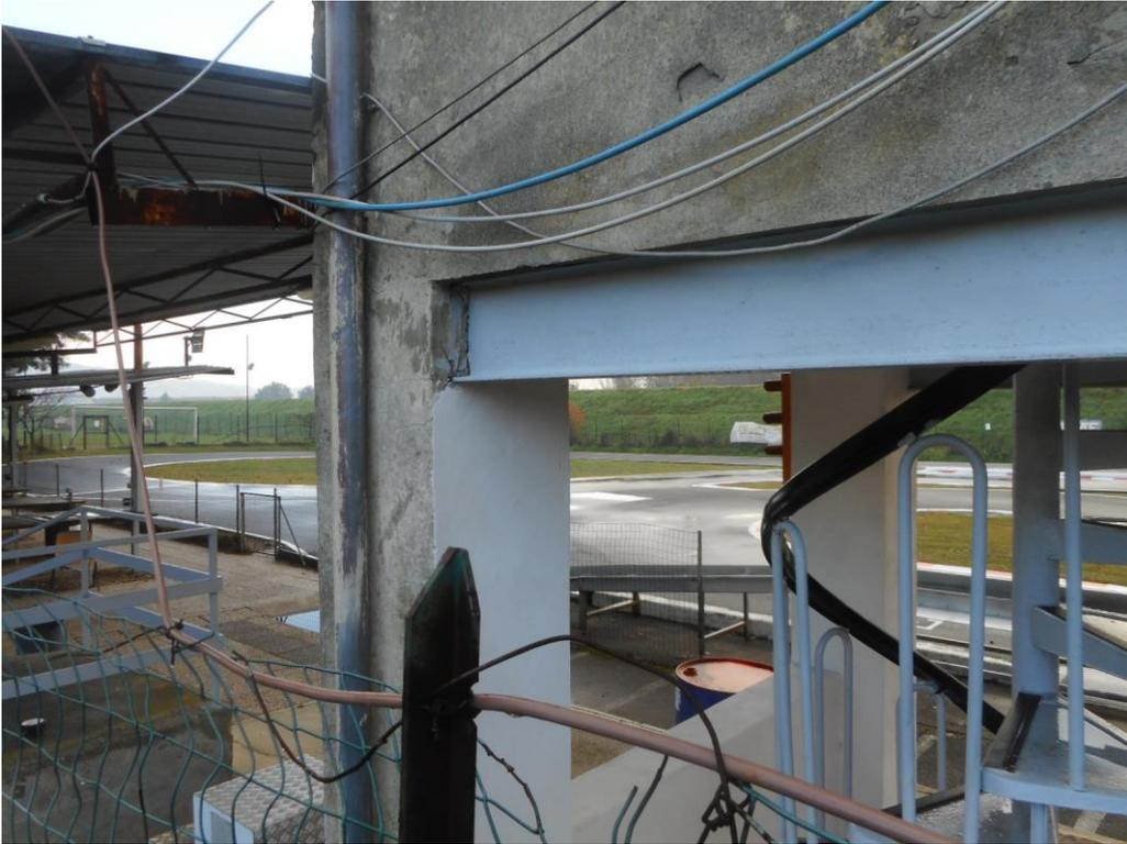
*Pilastri oggetto di verifica (interamente realizzati in bozze di calcestruzzo)*
