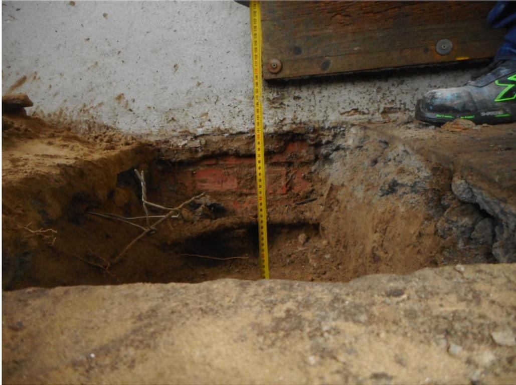
*Dettaglio della base di appoggio della muratura – Saggio F1*
