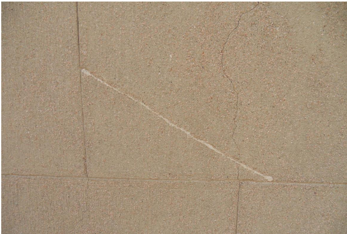
La foto evidenzia il particolare di un concio (lato Nord) attraversato da una finta venatura bianca, costituita da un impasto di calce
