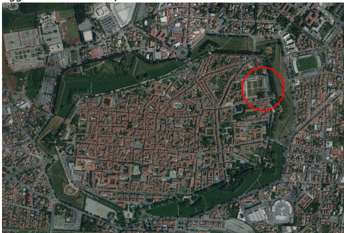
Ortofoto Agea 2019 inquadramento dell'edificio in oggetto (cerchio rosso) all'interno del centro storico di Lucca
