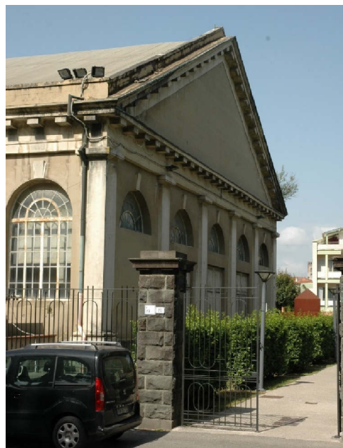
6 - Testata lato nord
