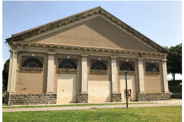
4 - Testata lato sud
